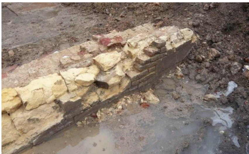
Afb. 7.4 Detail van het metselwerk van spoor 34. Het hier zichtbare baksteenwerk zal een inboeting zijn. Ook het mergelwerk zal een latere aanpassing van het oorspronkelijke bouwwerk betreffen.
