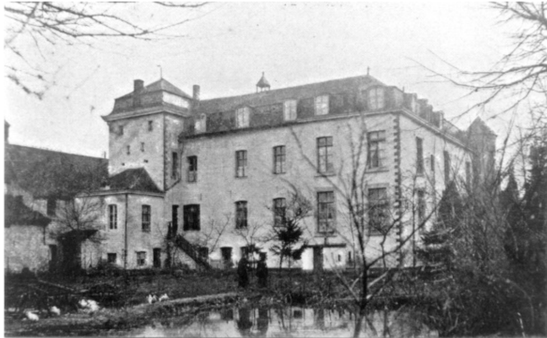
Afb. 4.2 Het kasteel gezien vanuit het noorden met op de voorgrond de vijver. Links is de vierkante toren zichtbaar. Tegen de toren is een aanbouw geplaatst. Van deze aanbouw zijn de funderingen tijdens het onderzoek aangetroffen. Omdat dit de enige kleine uitbouw is die tegen het huis is geplaatst zal dit de uitbouw zijn waar men in 1887 de scheidingsmuur met de kapel uitbrak om de kapel te kunnen vergroten. De kapel zal zich dus ter plaatse van de begane grond in de vierkante toren hebben bevonden. Aangezien de kapel zich bevond op de plaats van de oude biljartkamer was deze dus in de vierkante toren ondergebracht. (Herkomst: Coll. Stichting Eijdsens Verleden).
