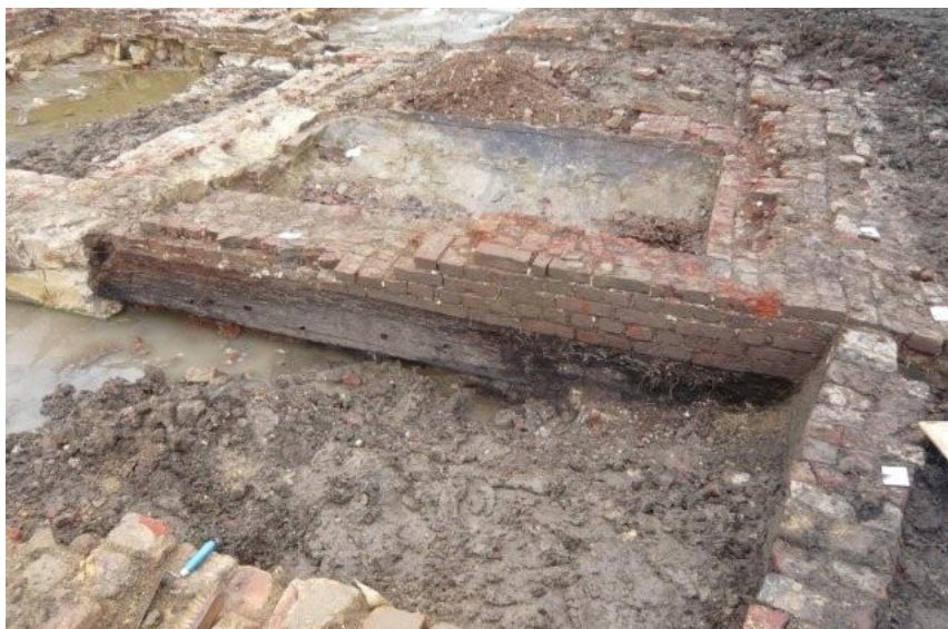
Afb. 7.15 Detail van de fundering van spoor 31. Dit is de uitbouw die tegen noordzijde van de oorspronkelijke toren is geplaatst. Dit in kruisverband uitgevoerde metselwerk is aanzienlijk zorgvuldiger uitgevoerd dan het metselwerk van de sporen 1 en 3. Het metselwerk is geplaatst op een zware vierkante balk. De gaten die in de zijkant van de balk zichtbaar zijn duiden erop dat de balk hier is hergebruikt.
