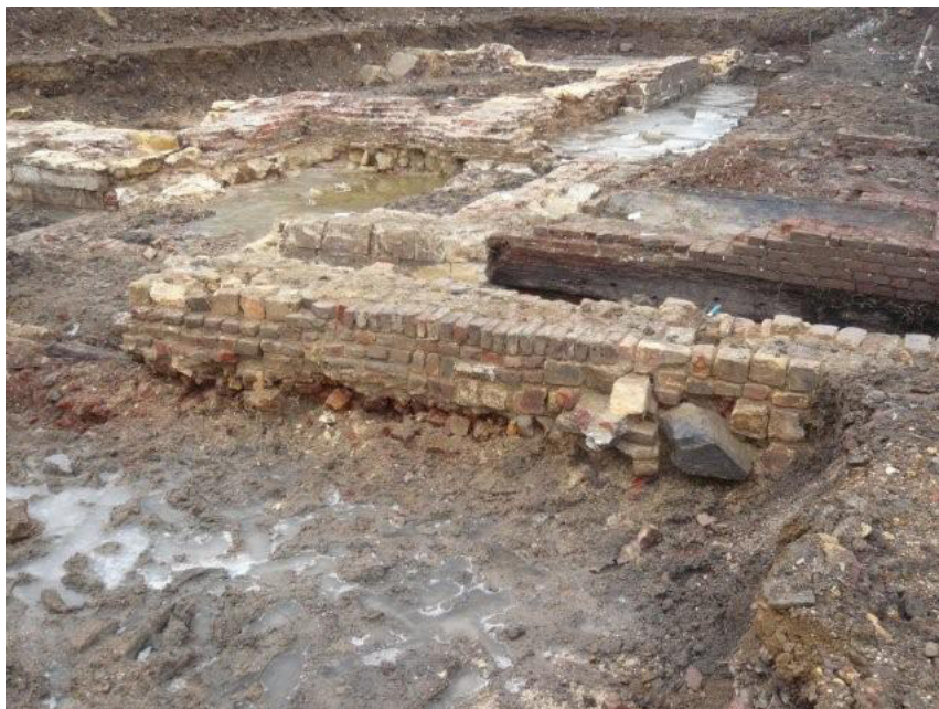
Afb. 7.19 Spoor 3 is de fundering van de in 1889 tot stand gekomen uitbreiding. Hier is de zeer slordige uitvoering van het metselwerk zichtbaar. Aan de bovenzijde van het bewaard gebleven deel van het fundament is een deel van de bakstenen in een rollaag verwerkt. In het metselwerk zijn naast baksteen en mergel ook kunststeen en (hergebruikte) hardsteen toegepast. Geheel links is nog net een deel van de houten balken zichtbaar waarop het metselwerk is opgetrokken.
