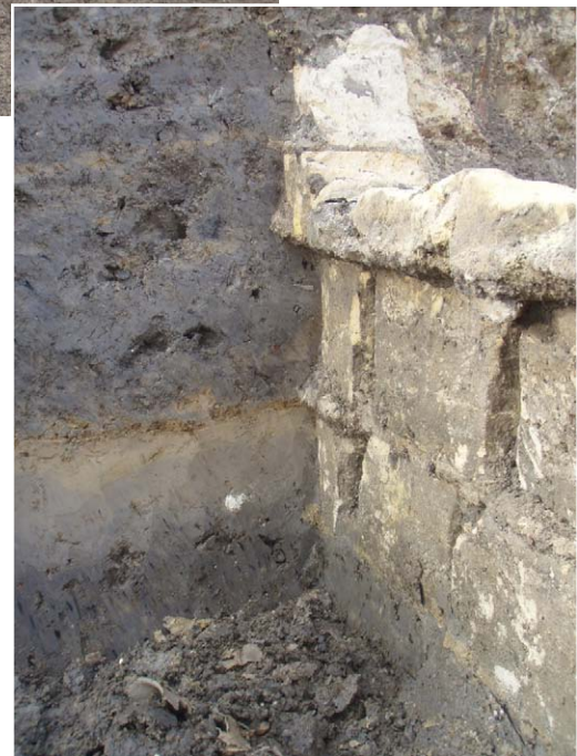
Afb. 6.11 Detail van de fundering in het profiel (het inmotten).
