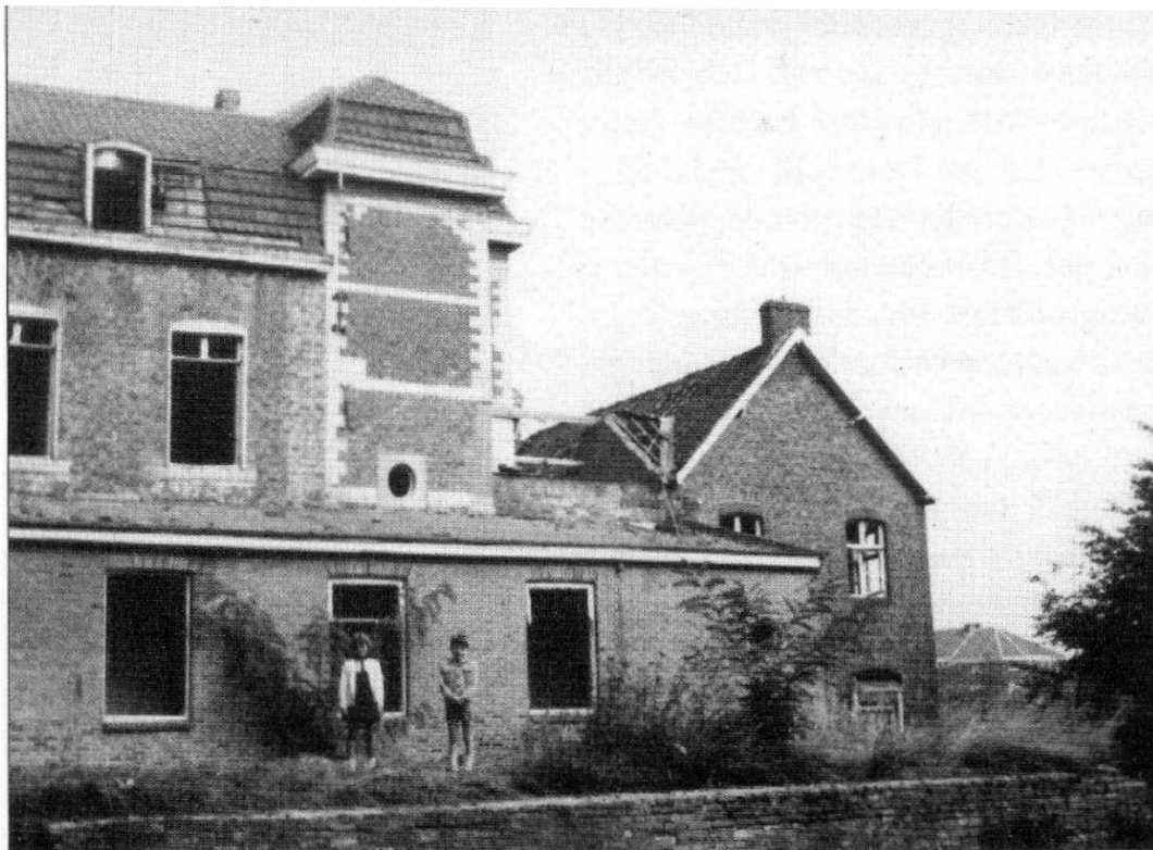
Afb. 4.3 Huis Bakvliet vlak voor de sloop. De veranda, die tegen de noordgevel was geplaatst, is in 1956 vervangen door een in baksteen opgetrokken gang. Zeer opvallend is het snelle verval van het huis voor de sloop. Normaal duurt het vele jaren eer een dergelijke toestand is bereikt. Een paar jaar eerder verkeerde het huis nog in een goede staat van onderhoud en werden er nog verbouwingen uitgevoerd. De slechte onderhoudstoestand werd als reden genoemd om het pand van de lijst van beschermde monumenten af te voeren. Hierdoor ontstond de ruimte voor het bejaardencentrum De Bron, dat inmiddels ook al weer is gesloopt (Herkomst: Huijnen, 2002, 17).
