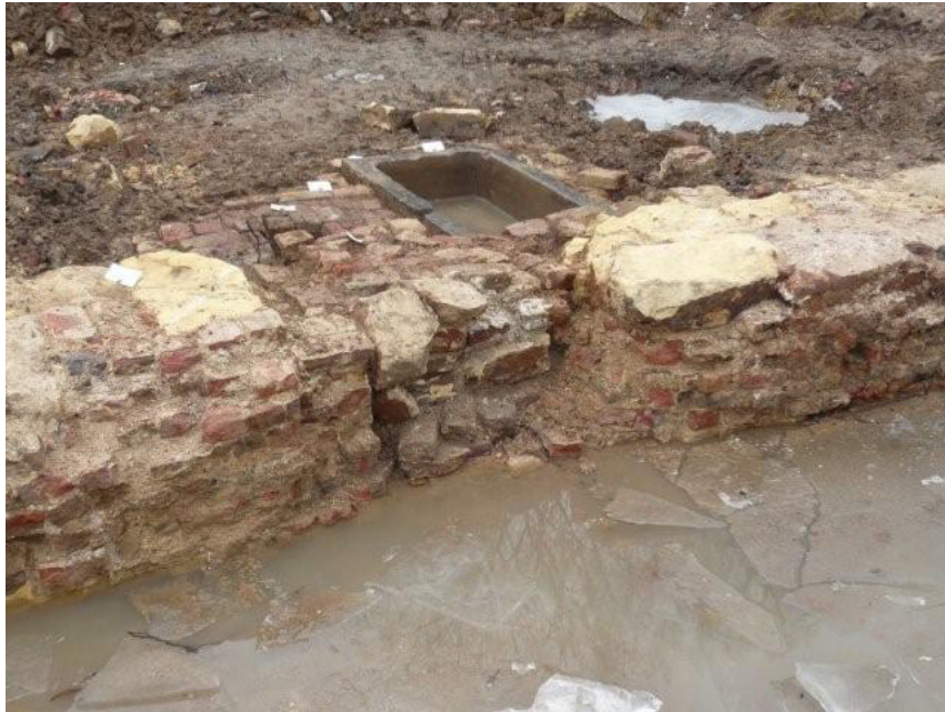
Afb. 7.8 Detail van de noordgevel van de toren, gezien vanuit het zuiden. Aan de andere zijde bevindt zich een hardstenen bak. In het metselwerk is een doorvoer opgenomen. Zichtbaar is dat het metselwerk van de doorgang een herstelling in het bestaande metselwerk is (zie ook de volgende afbeelding).
