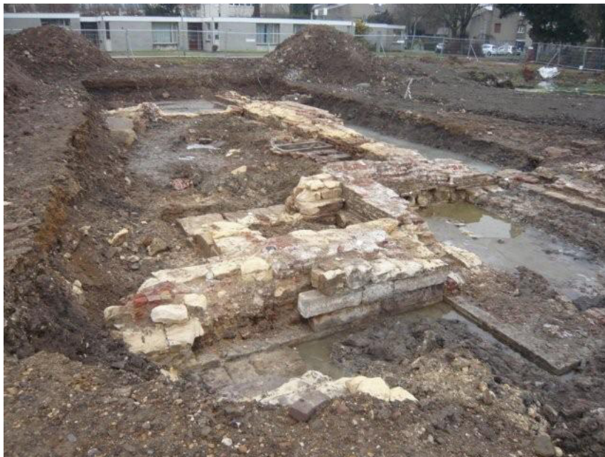
Afb. 7.11 De opgegraven fundering gezien vanuit het zuidoosten. De vierkante toren is rechts op de foto zichtbaar. Het metselwerk ervan is aan de buitenzijde bekleed met hardsteen. Dit deel stond in de kasteelgracht.
